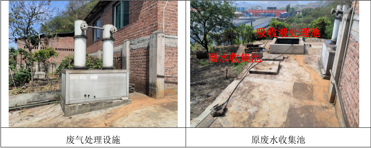
图 4.1-8 调查地块内排污及环保治理设施
