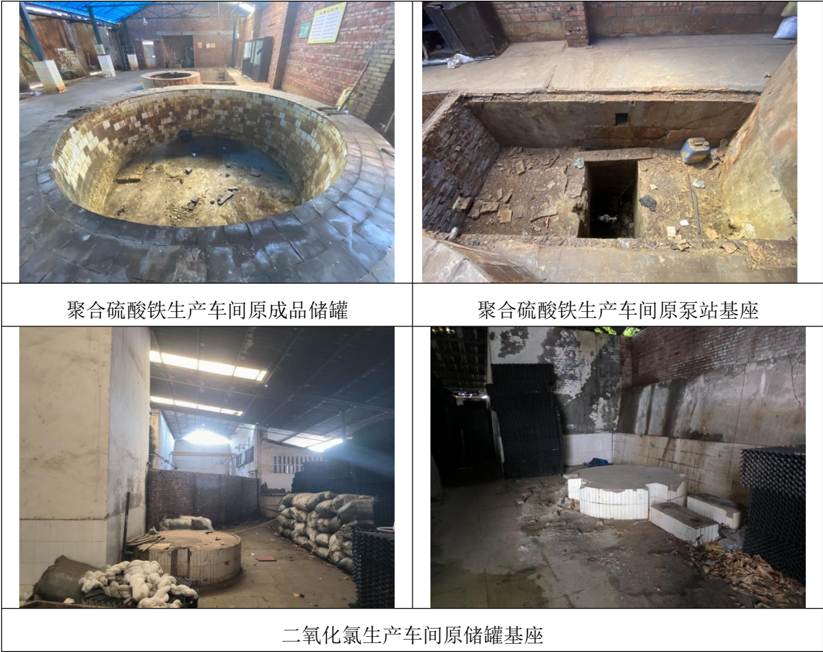
图 4.1-7 调查地块内暂存及转运设备
