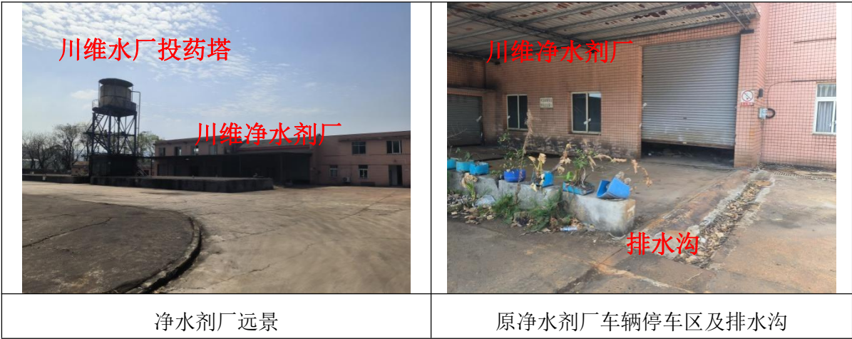
图 4.1-2 川维净水剂厂外观照片
