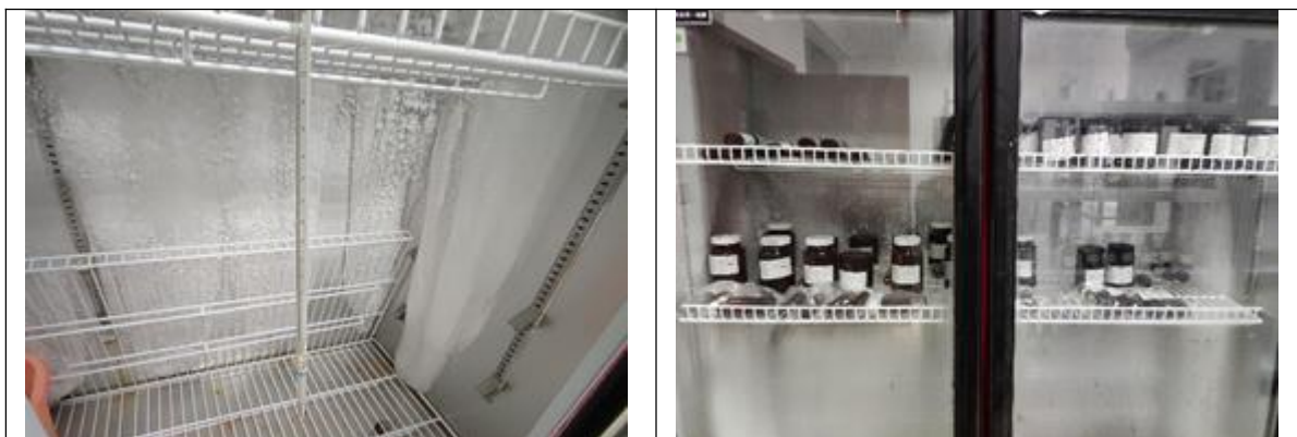
图6.4-2 港庆测控实验室样品保存区照片
