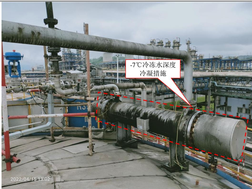
图 4.1-4 联合罐区呼吸废气-7°C 冷冻水深度冷凝措施
