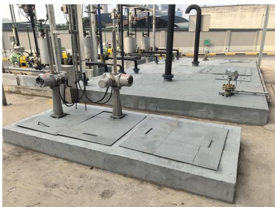
装置区雨污切换阀
