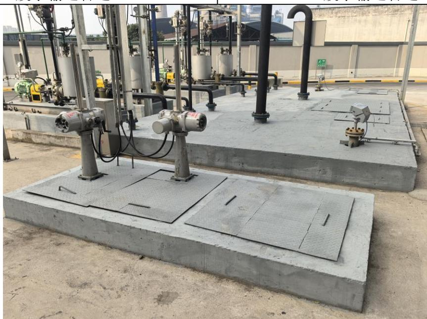
装置区废水收集池及雨污切换阀
