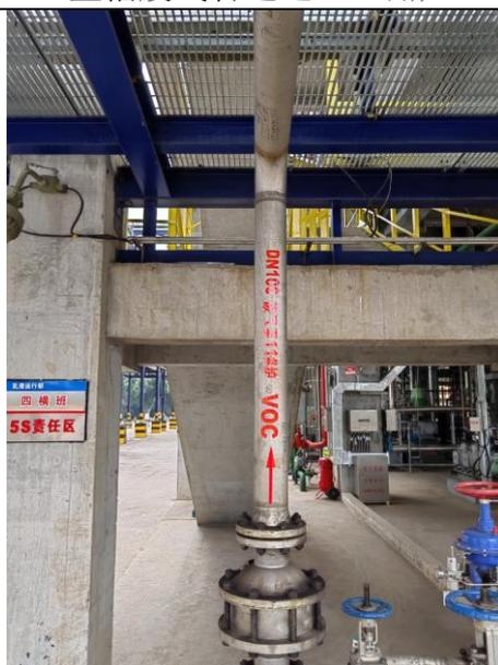
聚合单元脱泡气、VAC 缓存罐、VAC 计量槽废气管道送 11#锅炉
