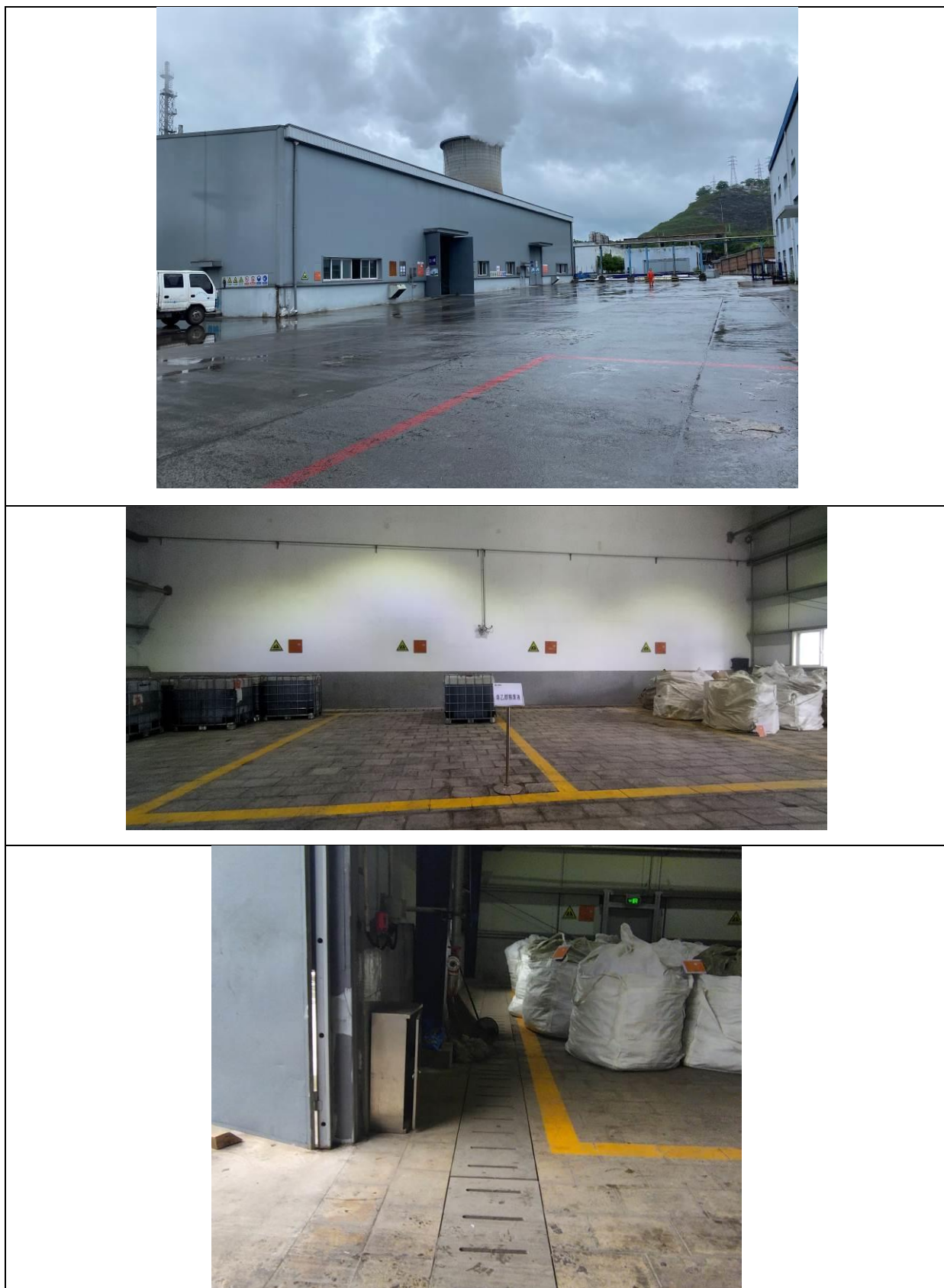
图 4.1-4 厂区危险废物贮存库（依托）
