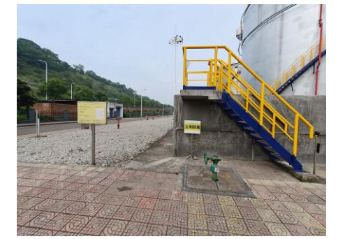
罐区雨水阀
